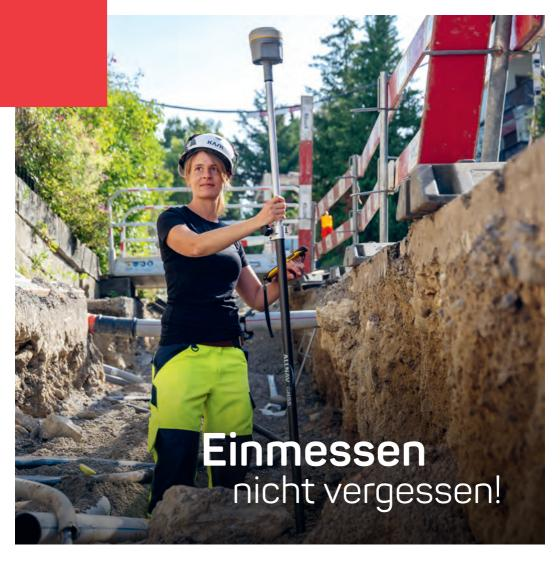
Die gesetzlichen Grundlagen verlangen, dass die Lage aller sich im Boden befindenden Leitungen (Strom, Gas, Wasser, Kanalisation usw.) in einem Plan festgehalten ist.
